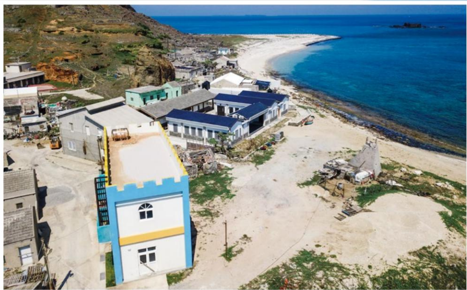
▲ 東嶼坪港口附近的許多建物は近幾年所新築，圖中水藍色牆壁 2 層建築為村民活動中心，其右側四合院式建築為嶼坪國小改建之遊客中心，村民活動中心後方則為衛生室。
