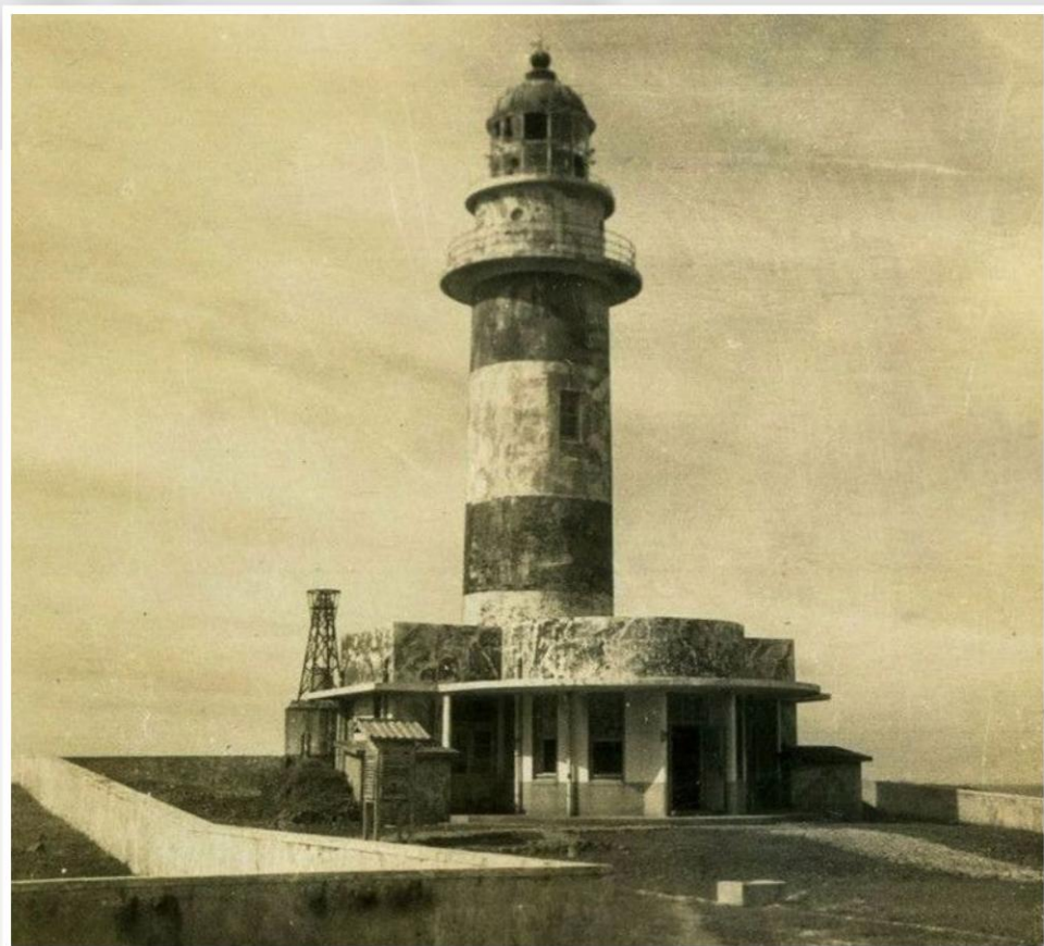
▲ 1946 年東吉燈塔，照明設備因轟炸而毀損，後方為第 1 代燈塔。
