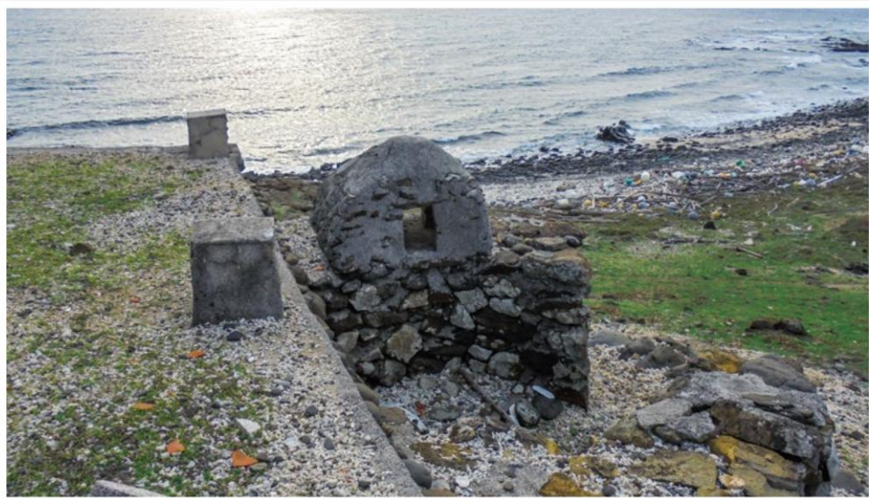
▲ 西吉嶼海上照明設施
