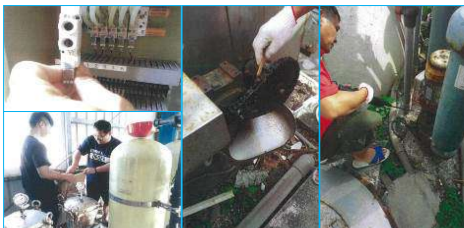
海水淡化廠濾材及機組 元件更換
